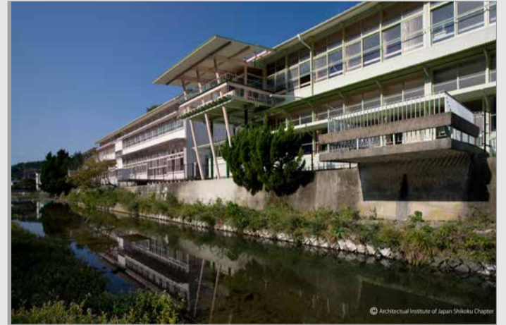
日土小学校 [photo: 北村徹]
